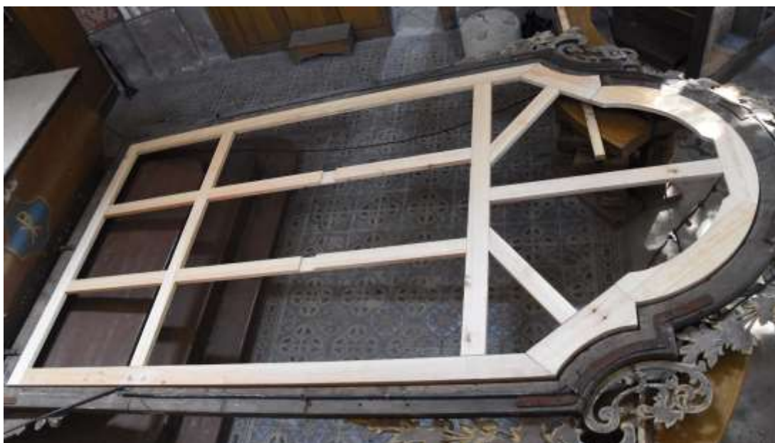
Kontrola rozměrů nového rámu vložením do rámu ozdobného
