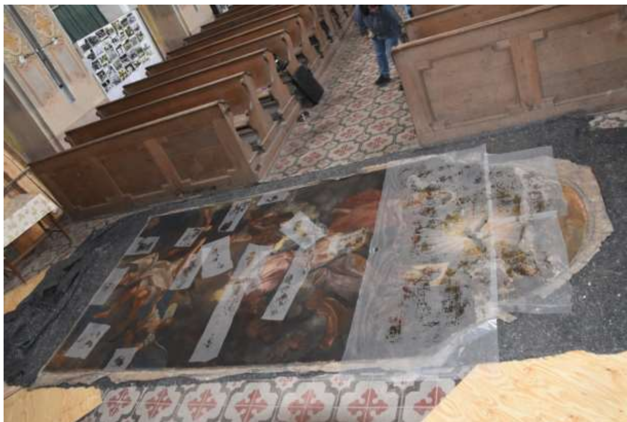
Stav po sejmutí obrazu z původního rámu (nahore) a po provizorním zajištění malby přelepem (dole) – příprava pro transport do restaurátorského ateliéru
